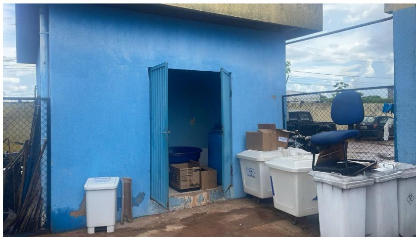
Figura 2: Central de Resíduos.
