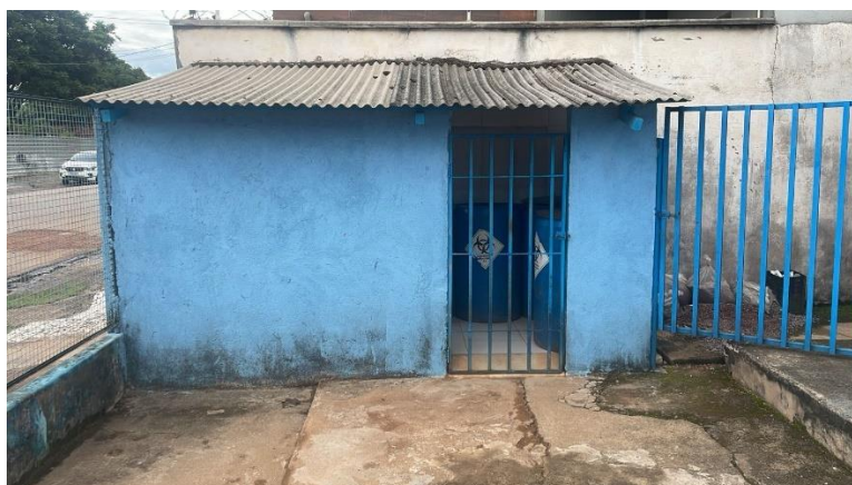
Figura 2: Central de Resíduos.
